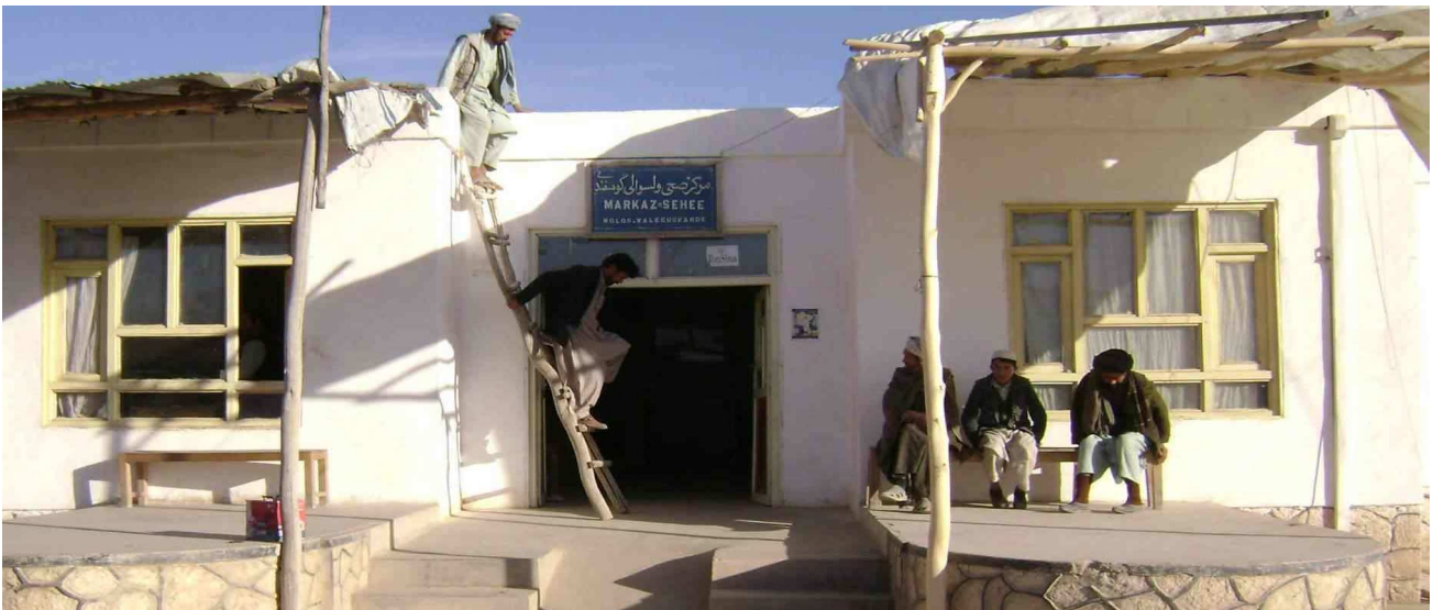
Hôpital de Gosfandi / Double vitrage et isolation du toit
