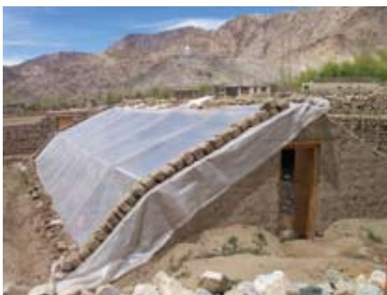
Фото 46 – Общий вид теплицы, где полиэтилен закреплен кирпичами.
