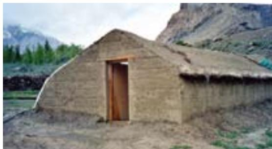
Фото 35 - Небольшой свес крыши с задней стороны теплицы в Спити.
