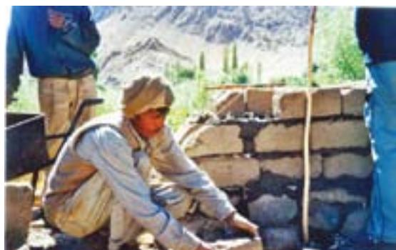
Фото 15 и 16 - Определение формы будущей стены при помощи веревки (в Кингае и Ладахе)
