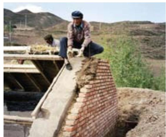
Фото 18 - Строительство внешней стены из обожженного кирпича и внутренней стены - из спрессованной земли с цементом в Кингае.
