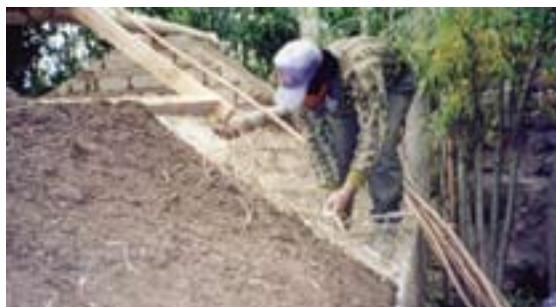
Фото 36 - Покрытие крыши картоном, соломой и глиной
