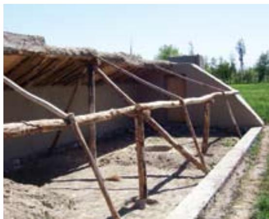
Фото 43 - Деревянная конструкция для поддержки полиэтилена (Ловгар, Афганистан)
