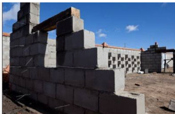
(В)Өрлөгийн төмөр, цонхны ялуу суулгасан блокон хана
