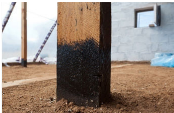
(D) Тулгуур баганыг хар лакаар лакдан хамгаалсан байдал
