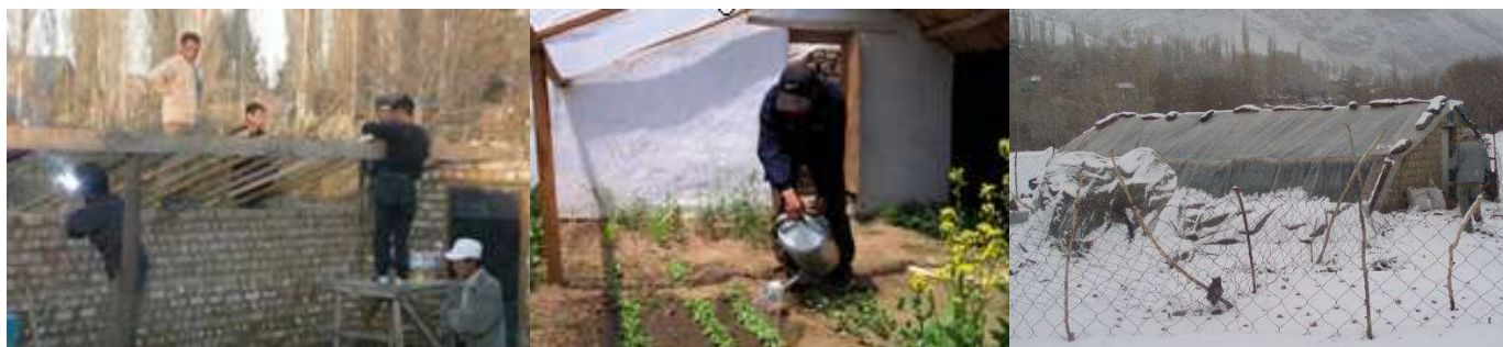
Des artisans construisent une serre solaire passive permettant la culture maraîchère pendant la saison hivernale.
