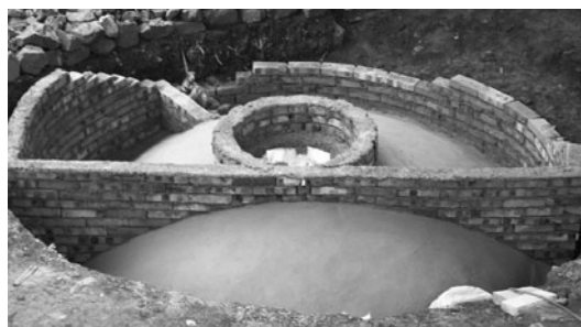
Fixed dome biodigester (©Initiative Développement)
