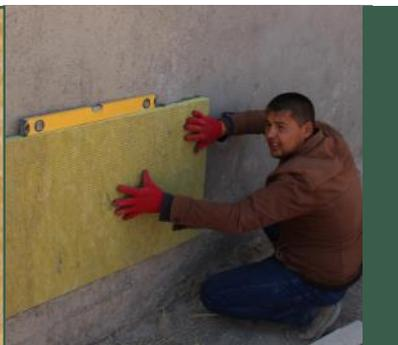
При монтаже утеплительных плит следить за вертикальностью и горизонтальностью с помощью
