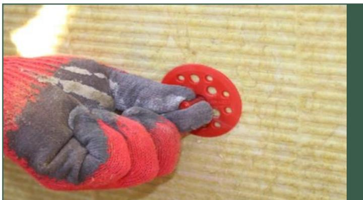
Плита из минеральной ваты имеет значительную массу. Клеящий раствор должен наноситься сплошную. Расход пластиковых дюбелей 5 – 7 штук на 1 м<sup>2</sup>
