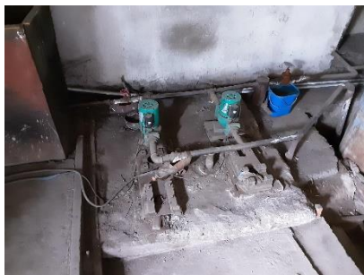
Зуухны өрөөний байдал
