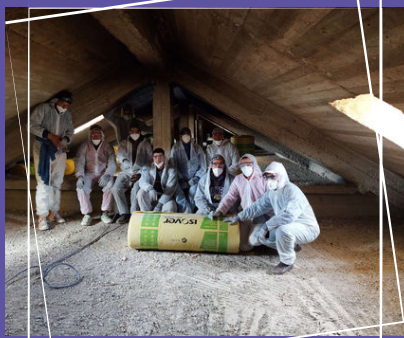
Isolation de la toiture de l'internat de l'école communautaire de Zaouiat Sidi Hamza
