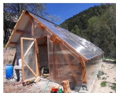
SERRE « 3 MURS » Péone (06)
